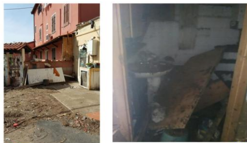
Interventi a sostegno famiglie città di Livorno: rifacimento tetto, ripristino bagno
